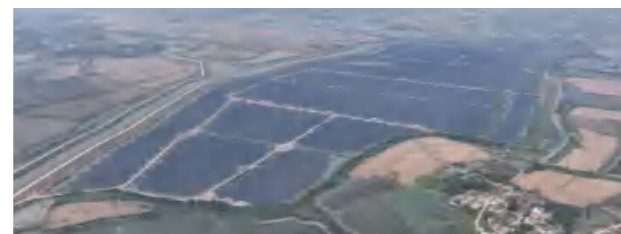
和县功桥镇100MW渔光互补光伏发电项目
