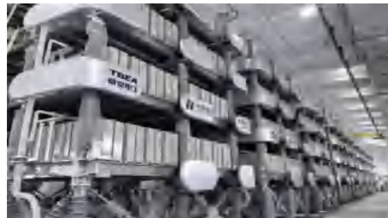
柔性低频交流输电T-HVAC-300换流阀
